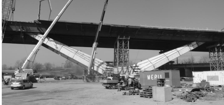
Fig. 5. I cavalletti nelle ultime fasi costruttive
