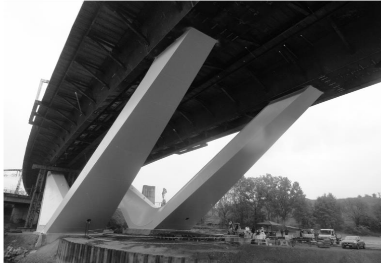
Fig. 2. Vista degli impalcati maggiori e delle pile a cavalletto
