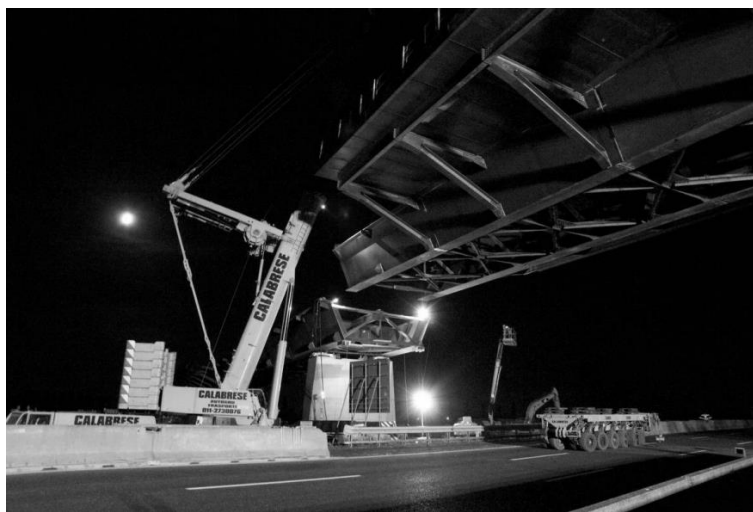
Fig. 7. Sollevamento in notturna degli impalcati di scavalco A1
