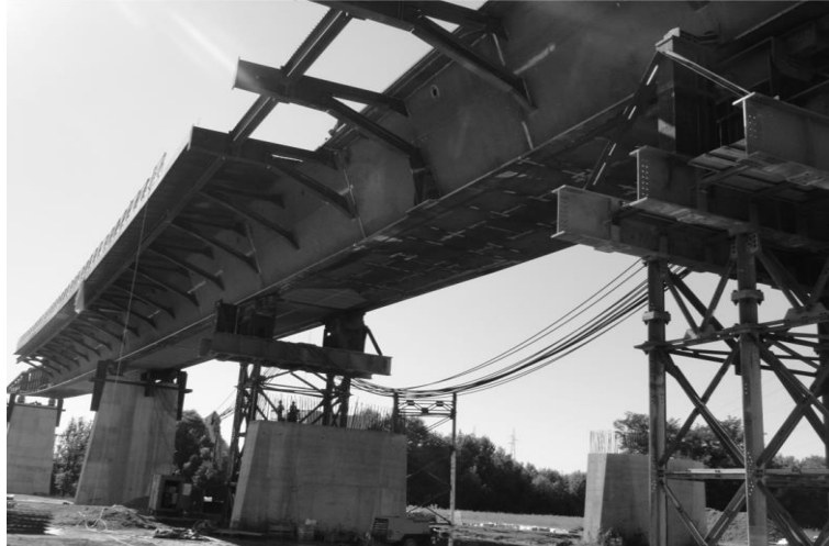
Fig. 8. Vista del “treno di varo” con il sistema di spinta in quota
