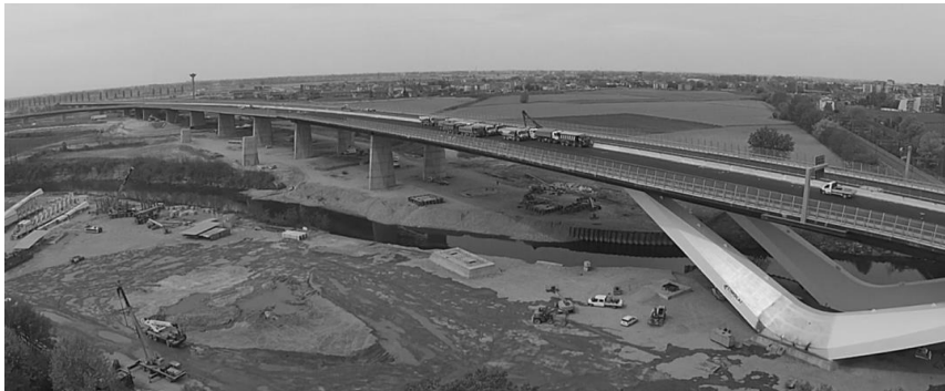
Fig. 1. La nuova Tangenziale Est Esterna di Milano, A58 - Melegnano
