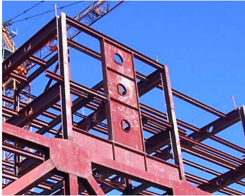
Figura 2: Controvento longitudinale superiore
