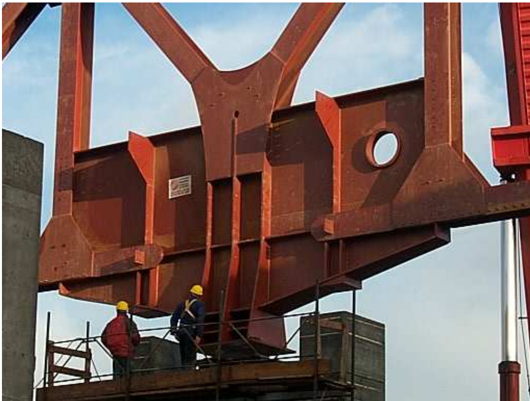
Figura 4: Elemento di appoggio
