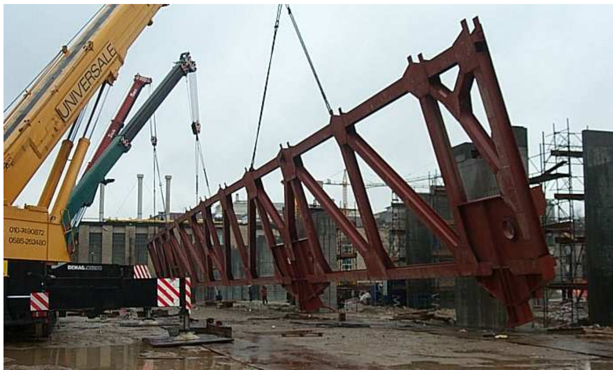
Figura 6: Raddrizzamento travatura reticolare
