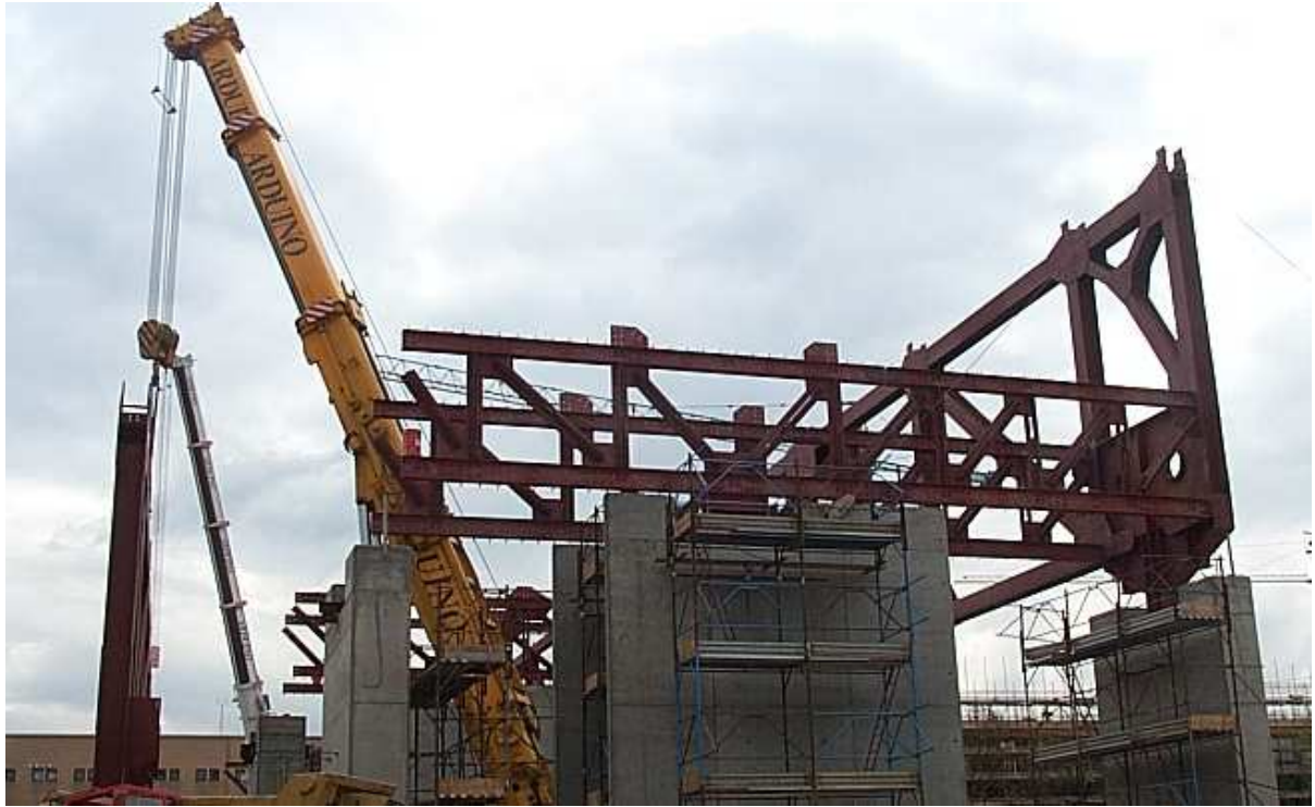
Figura 8: Sollevamento sugli appoggi definitivi della seconda trave
