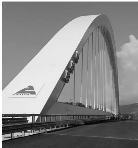
Fig. 5: Aperture per la ventilazione naturale
