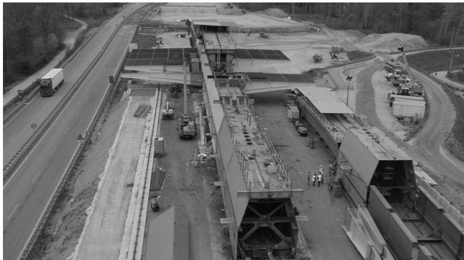
Fig. 3: Varo dell'impalcato con predalles metalliche
